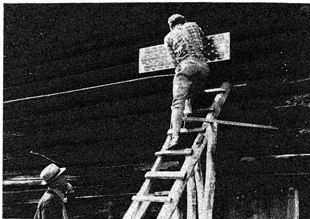
Abb. 2: Montage eines Kollektors mit  $\frac{1}{3}$  m<sup>2</sup> Siliziumzellen, 16,1 V – 2,05 A.
